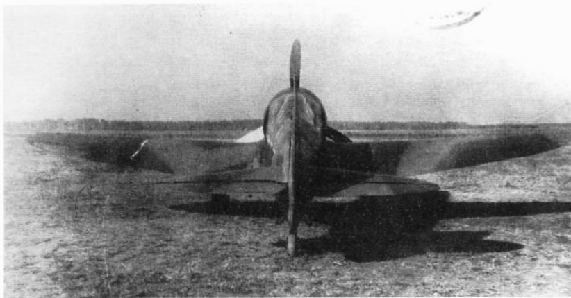
Завод №21 часто допускал искажение формы камуфляжных пятен. Сверху и снизу: Улучшенный самолет Ла-5Ф №39210109, построенный в августе 1943г. Маслорадиатор установлен под фюзеляжем между 3 и 5 шпангоутом. Фонарь кабины вместо подвижной имеет откидную (в правую сторону) часть.
